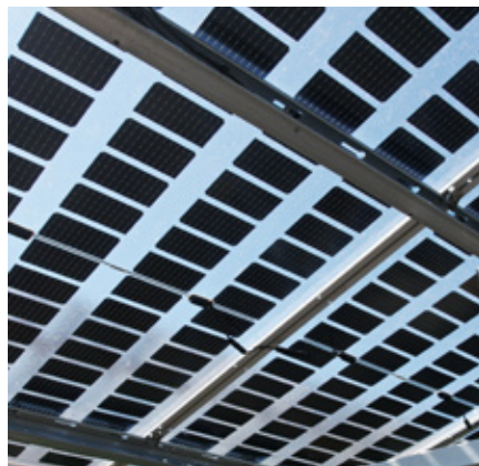
Die „verbesserten Zebromodule“ der Erstinstallation lassen etwa 50 % des einfallenden Lichtes durch und sind miteinander durch Abdeckungen verbunden.
